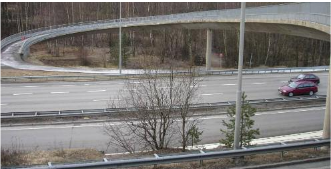
E18 ved utløpet.
